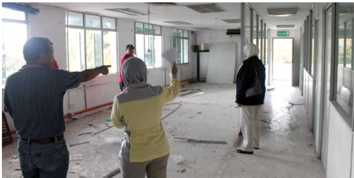
Kerja-kerja Pembaikan Di Tingkat Atas Bangunan Pada 19 November 2012
