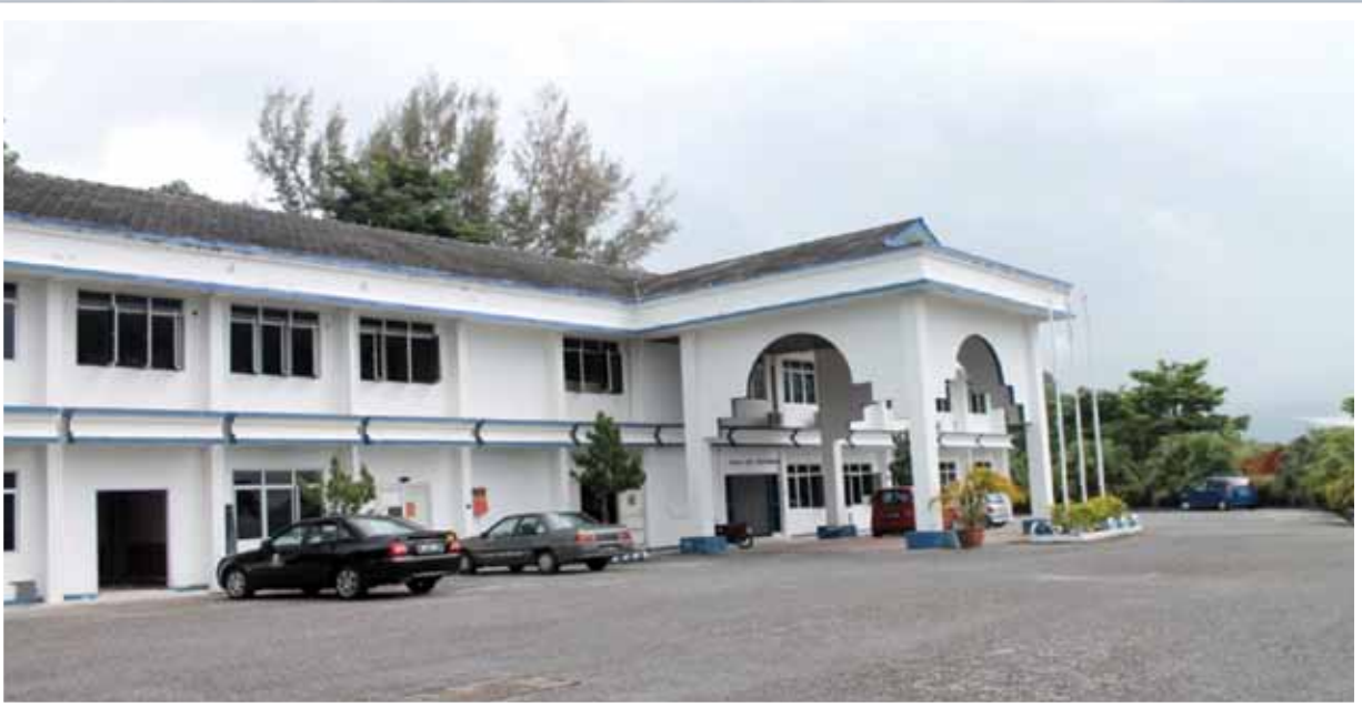
Pandangan Sudut Kanan Bangunan Daerah Maritim 1 Langkawi Selepas Selesai Pembaikan.
