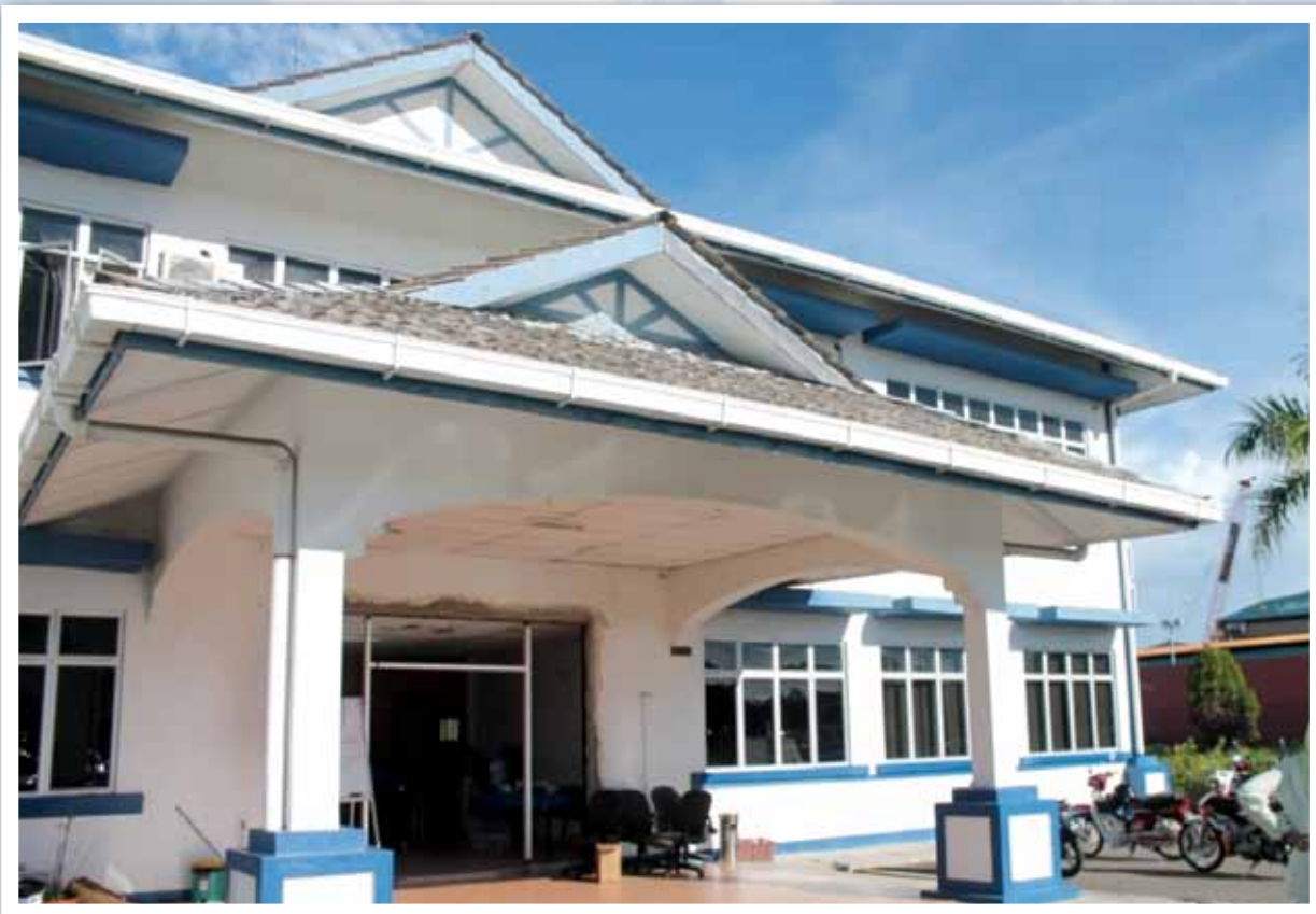
Pandangan Sudut Kanan Bangunan Semasa Kerja-kerja Pembaikan Dilakukan
